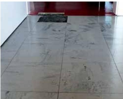
Asbest als Bestandteil von alten Fußbodenbelägen aus Kunststoff (Floor-Flex-Platten)
