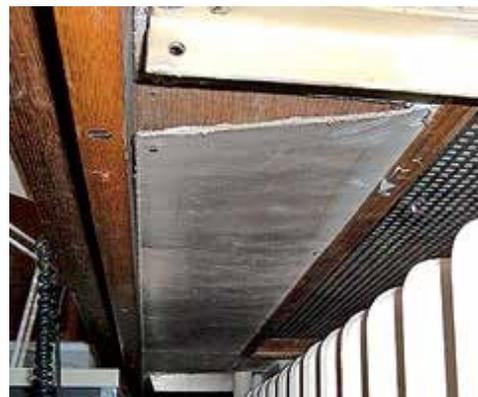
Asbestpappe unterhalb eines Fensterbretts
