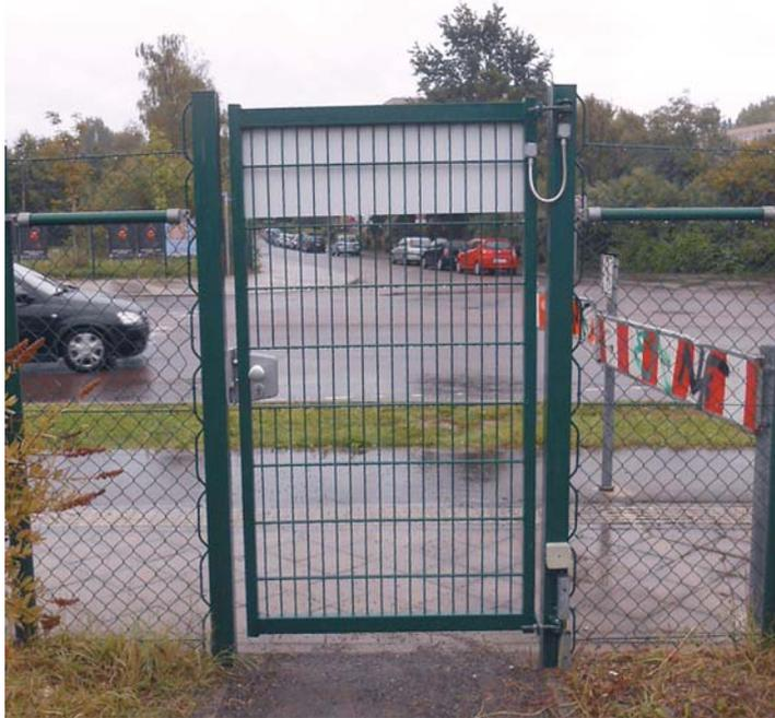
Hier wurde von einer Fachfirma eine mit Zeitschaltuhr gesteuerte automatische Schließanlage installiert.
